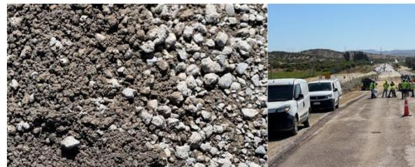
*Fig. 7. Detalle de la base granular del tramo de prueba.*
