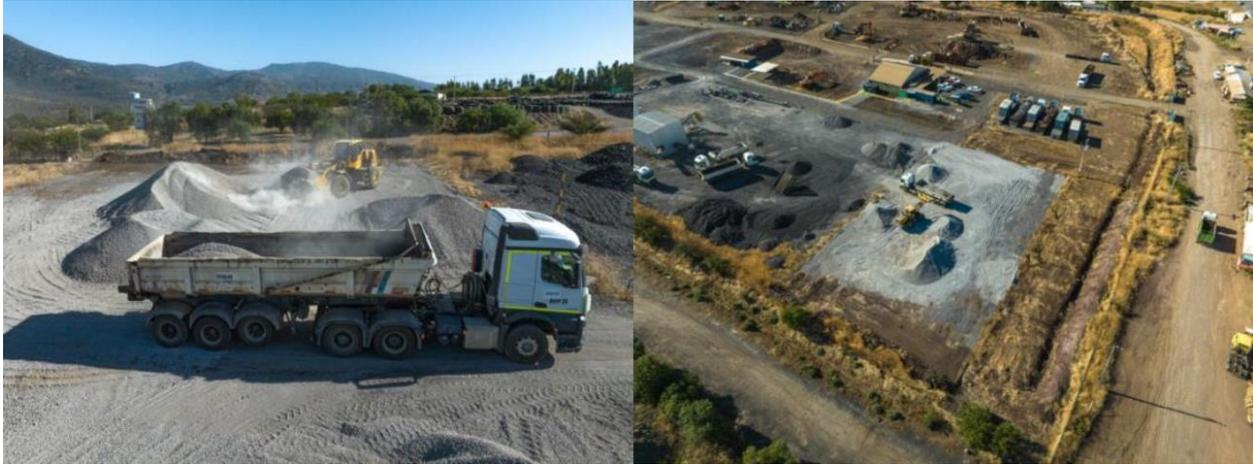
*Fig. 5. Recolección y acopio de ARH para ser empleado como base granular.*
